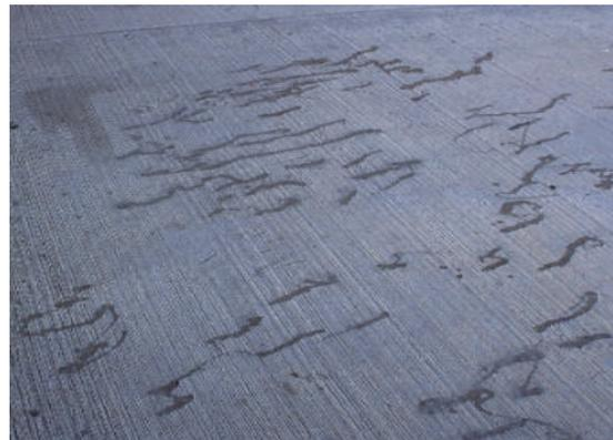
Figura 7.3: Fissuras com injeção de resina epóxi
