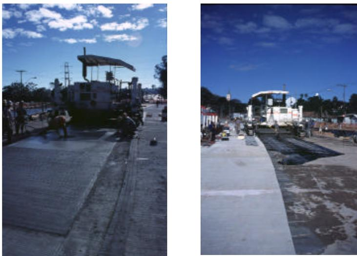
Figura 7.4: execução do pavimento em concreto da Av. Terceira Perimetral com fibras de polipropileno
