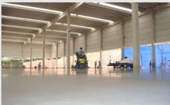
Seja qual for a etapa de acabamento de um piso em concreto, quando lançamos, aspergimos ou pulverizamos água sobre a superfície, passamos a incorporá-la a uma fina camada de argamassa a partir da movimentação dos discos de flotação ou do desempenho mecânico e das pás/facas das
