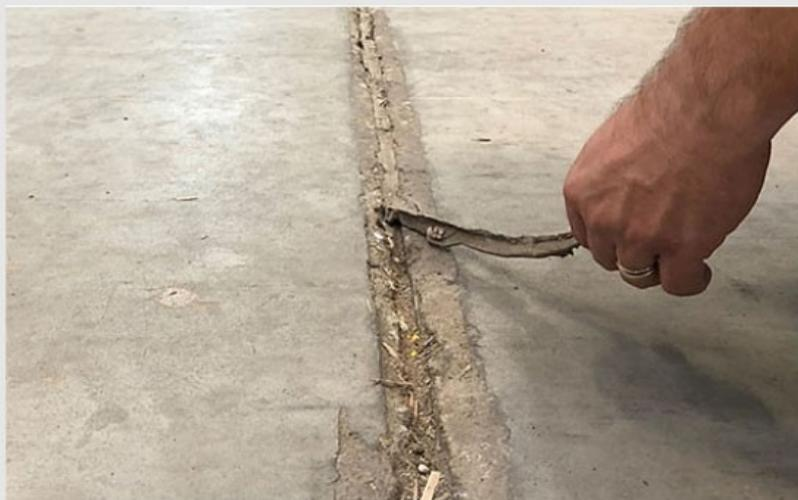
Figura 01 – Junta com descolamento do selante
