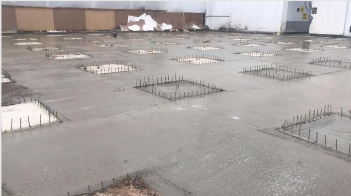
Base preparada com concreto magro para montagem das armaduras dos pisos estaqueados
