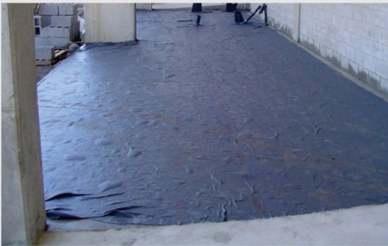
Figura 1 – Manta geotêxtil umedecida aplicada para cura úmida do piso de concreto
